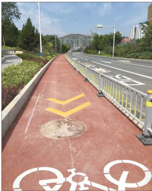
新修的旅游路部分透水性路面。 记者 蒋龙龙 摄
