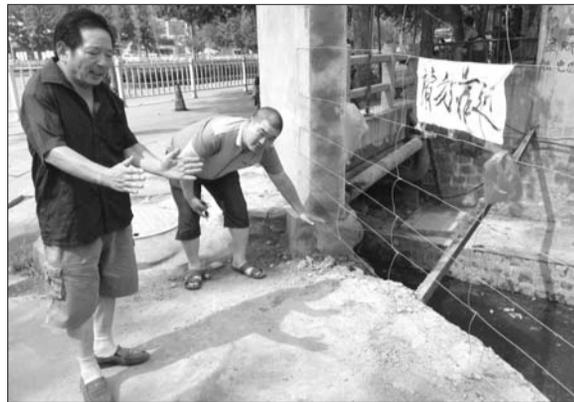
右侧铁网位置原先是围墙,1日围墙被拆掉,商户(左一)说,排水孔宽度太窄,造成雨水倒灌。 本报记者 赵兴超 摄
