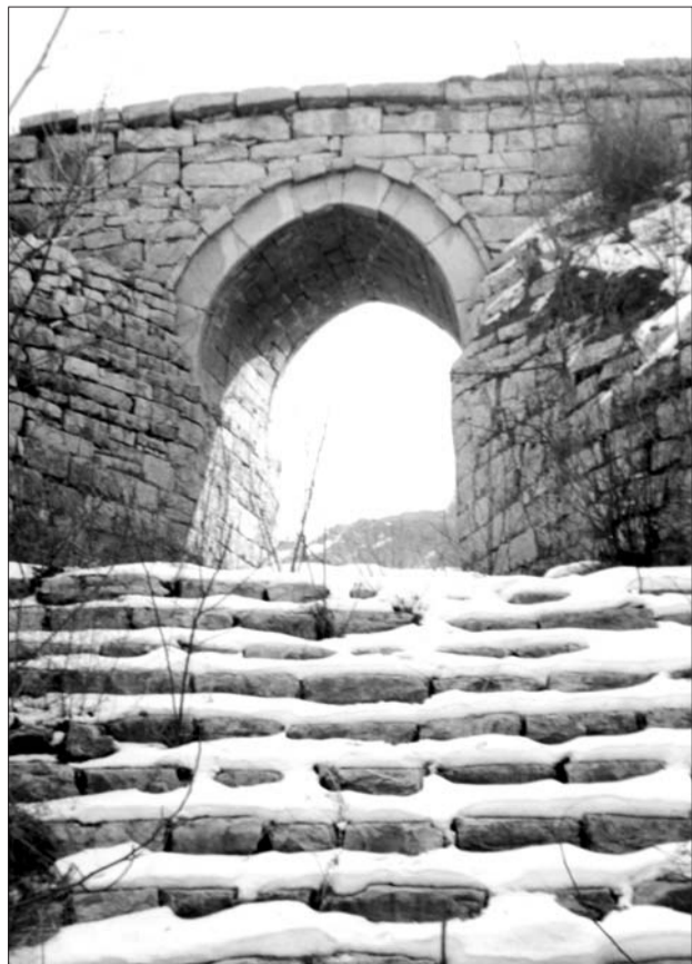
前封村大桥峪石桥。
