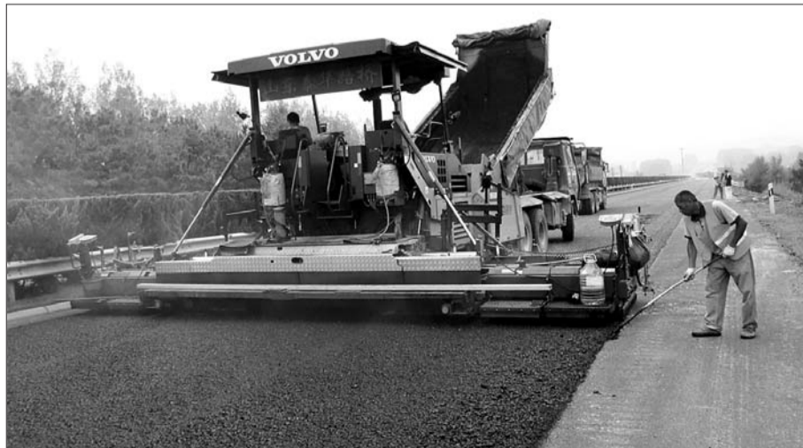
荣乌高速铺筑沥青下面层现场。通讯员 李其波 摄
