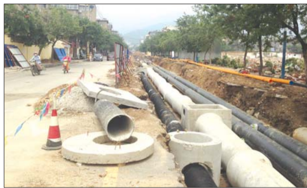
傲徕峰路正在铺设管道。 本报记者 王世腾 摄
