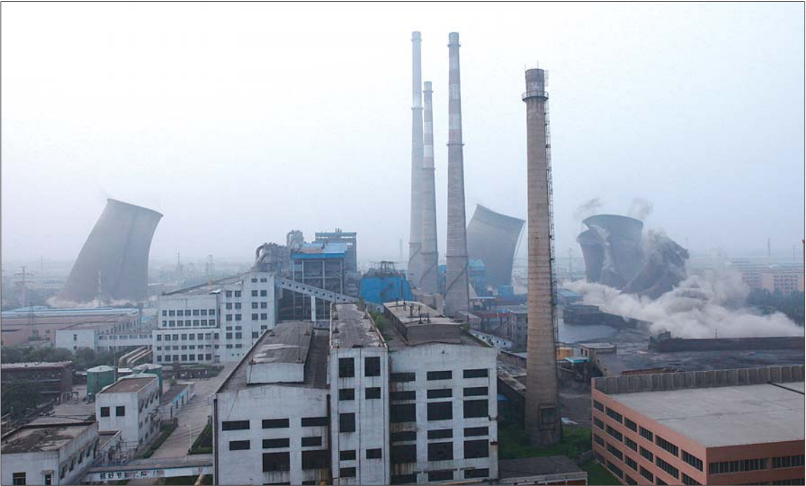
11日18时,在平国能热电有限公司七个冷却塔被爆破拆除。
