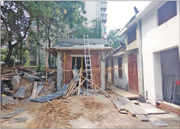
◀ 趵突泉公园内的泉水先观后用泵站仍在施工。本报记者 蒋龙龙 摄
