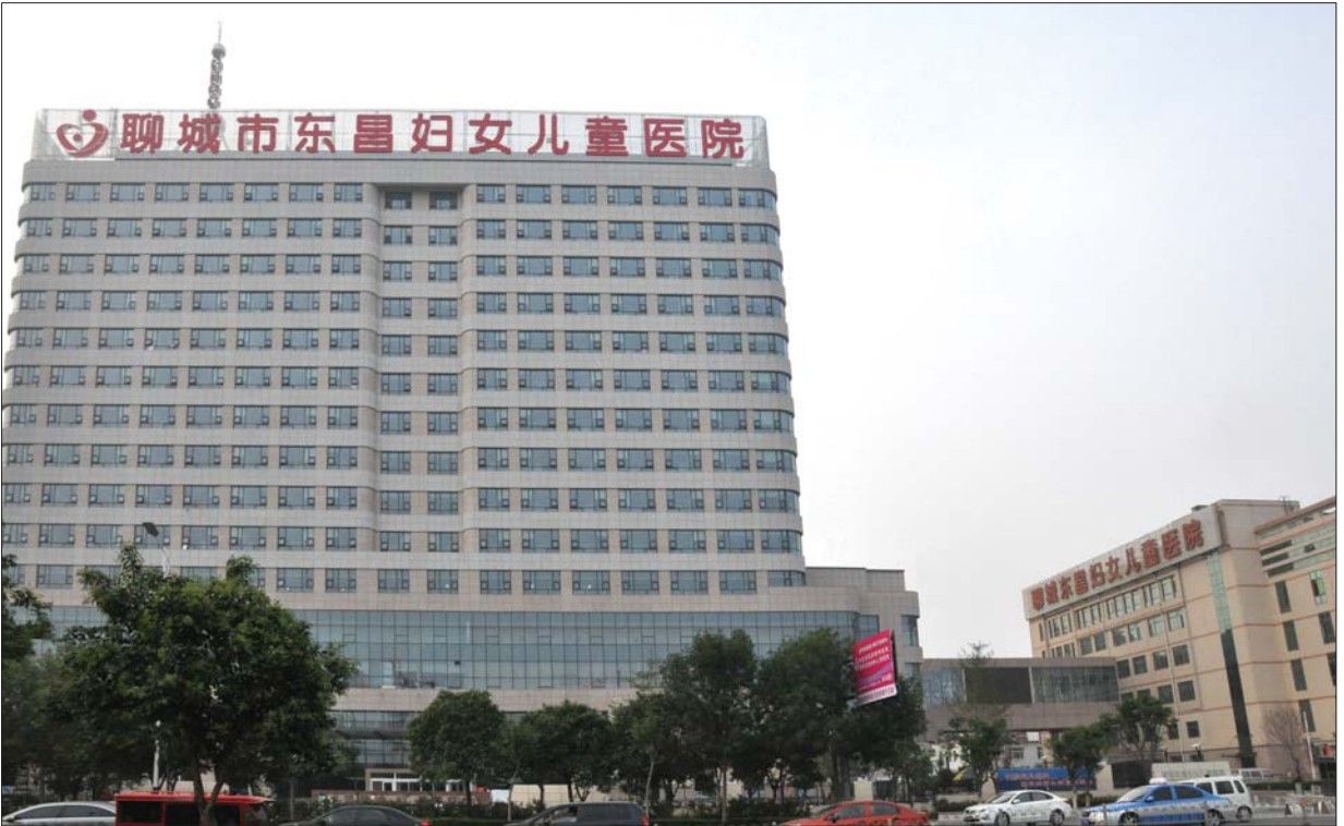
新运营的妇女儿童医疗保健大楼
