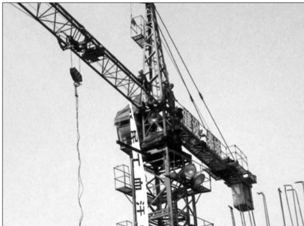
8名工人爬上塔吊不肯下来。 本报记者 张伟 摄
