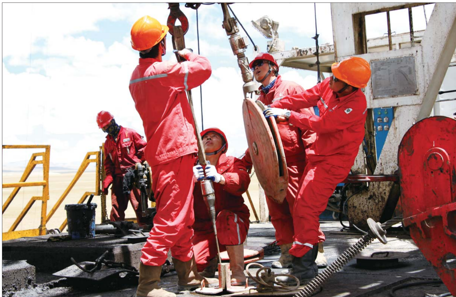
队员安装天地滑轮使仪器入井探测。
