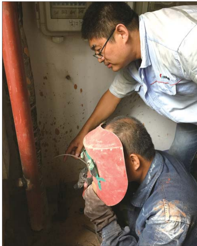
工作人员加班加点进行管道焊接工作。 记者 王倩 摄
