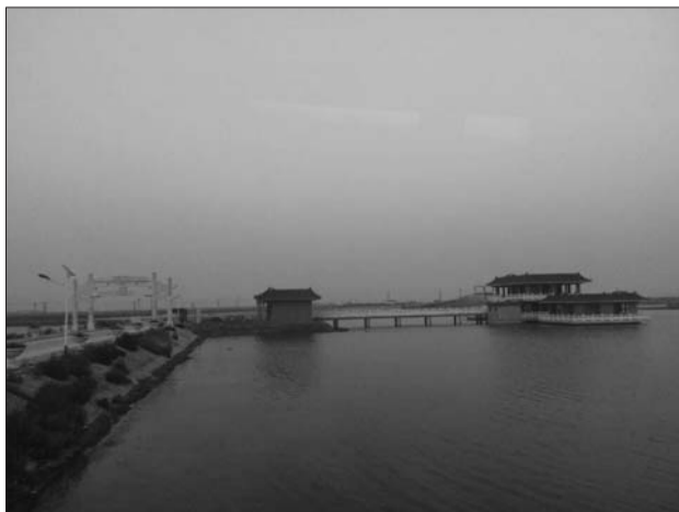
无棣县水沟村水上餐厅正在建设中,即将投入使用。
