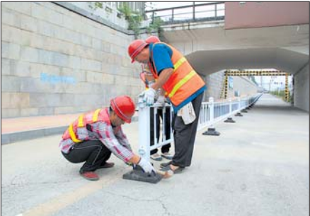
绣水大街铁路桥辅道改造现场。
