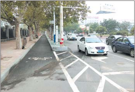
车站街北首东侧人行步道分离出非机动车道。
