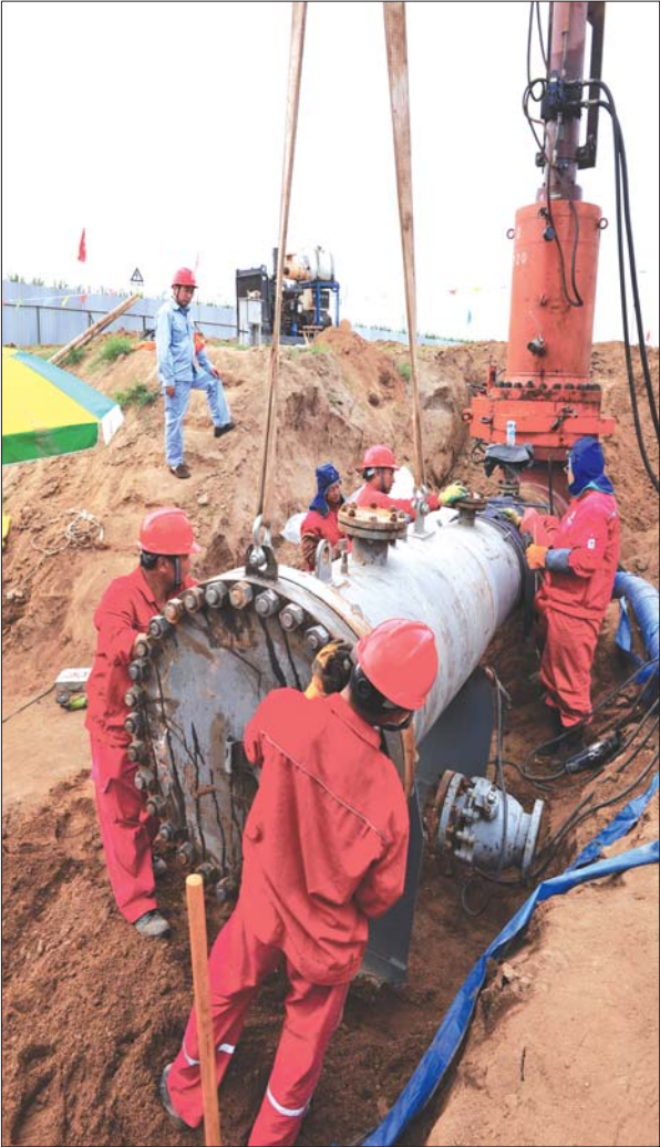
对管线盲板进行紧固。
