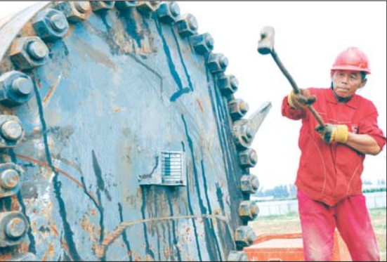
安装施工设备。
