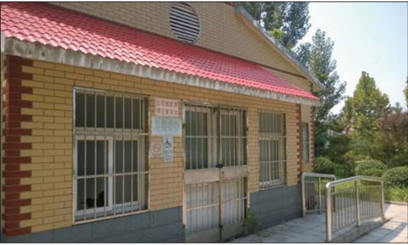
张店昌国路与世纪路交叉口处公厕大门紧闭。 本报见习记者 张朕宇 摄
