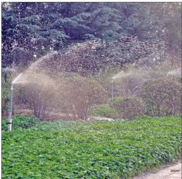
中水再利用,经十东路绿化带实现中水喷灌。
