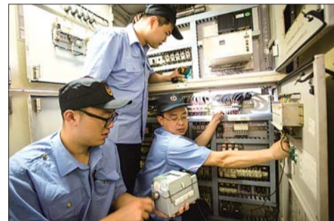
济南车辆段库检车间车电员测量车辆电器配线绝缘值。
