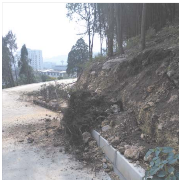
被大风刮倒的柏树。见习记者 张永宽 摄
