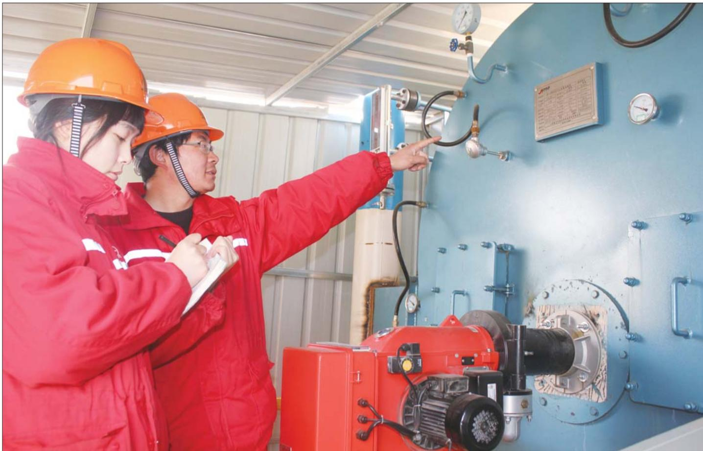
员工在高效加热炉旁记录掺水压力及稳定。
