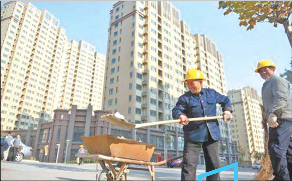
2014年11月14日,西蒋峪保障房小区,施工人员进行最后的打扫。(资料片) 本报记者 王媛 摄
