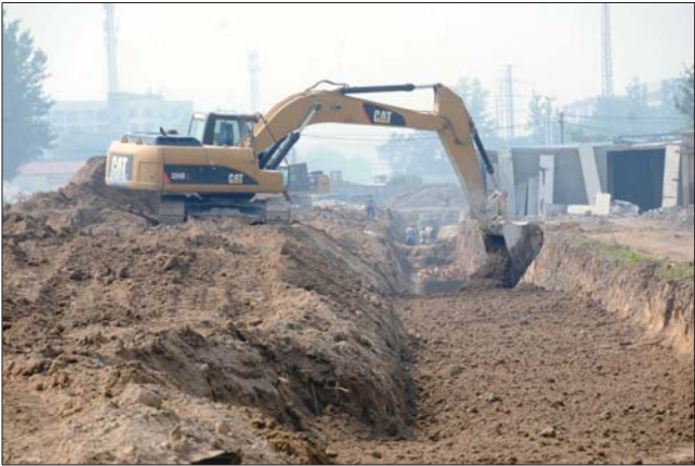
牡丹路北延工程施工现场。本报记者 邓兴宇 摄
