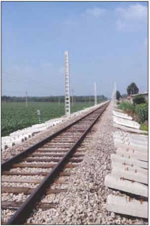
磁东线原有的木枕将换成水泥枕。 本报记者 王伟强 摄
