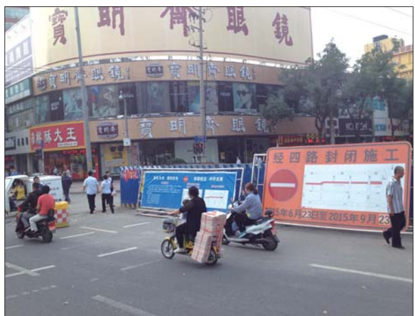
中秋期间经四路大纬二路以西道路仍将全封闭。
