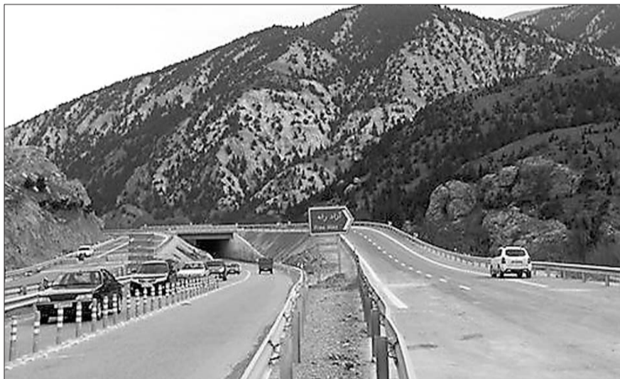
德黑兰-北方高速公路已建成一部分。(资料片)
