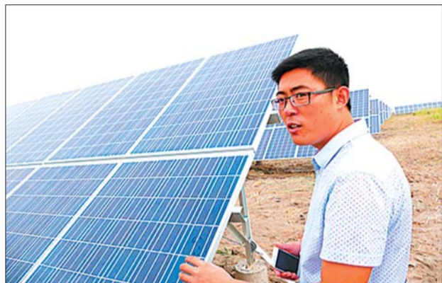
喀什市麦盖提力诺一期太阳能光伏发电项目占地750亩。
