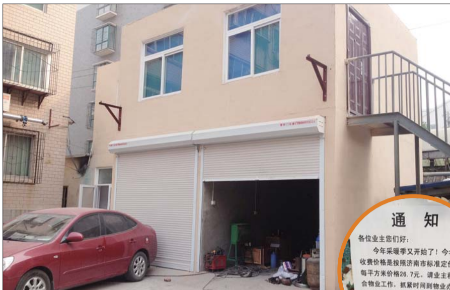
▲小区换热站已经开始汽改水的改造。
