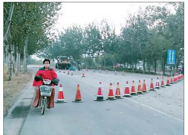
省道316正在整修,沿线设立了路障。
