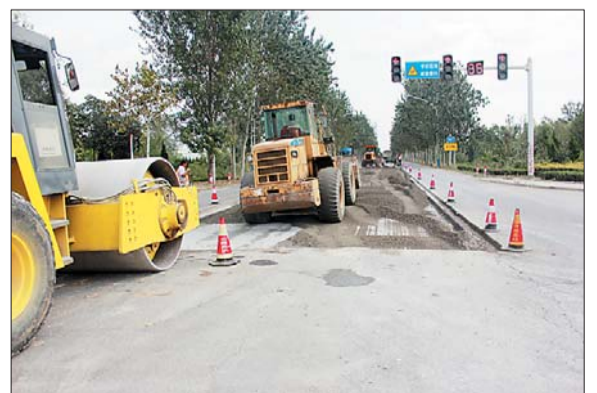
工作人员正在紧锣密鼓地施工中。
