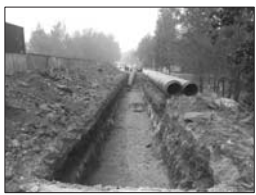
施工人员正在双力西路铺设供热管网。 本报记者 张召旭 摄
