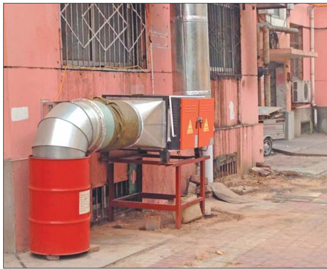
沿街楼饭店外的排污设施已被整改。 本报记者 张帅 摄
