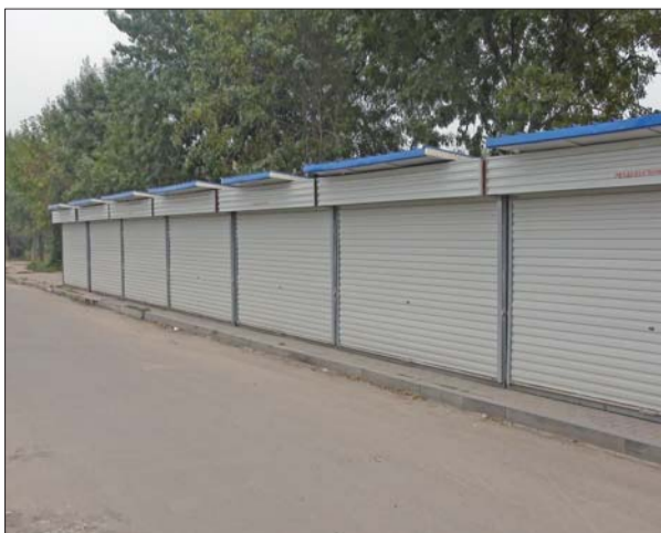
违规搭建的板房排列在人行道上。 本报记者 杨擎 摄
