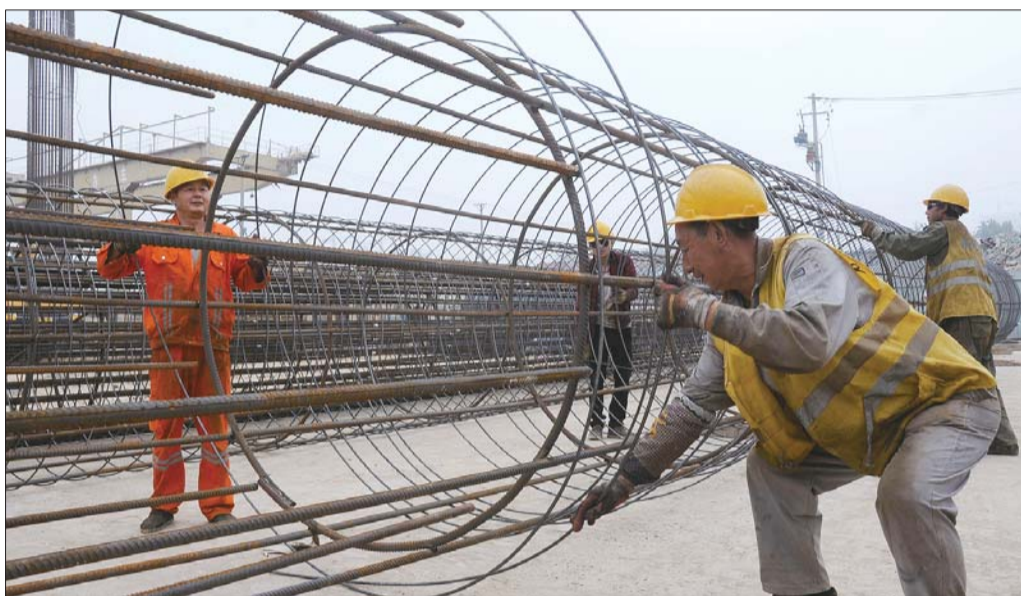
丹阳立交桥项目工人正在作业。
