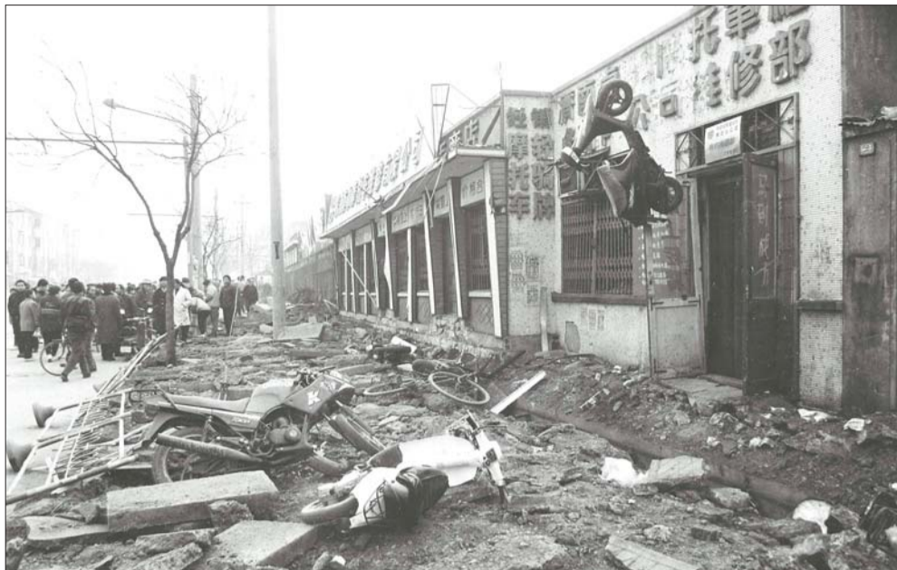
1995年1月3日18时,济南和平路煤气管道发生爆炸,人行道被炸成大沟,一辆摩托车被爆炸气流掀飞,挂在了旁边门头房的门框上。
