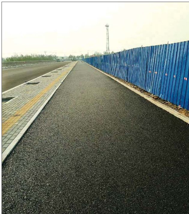
黄河十六路已达到通车条件,非机动车道沥青砼面层完成。
