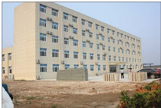
阳信县京阳石化股份公租房项目基本建成。
