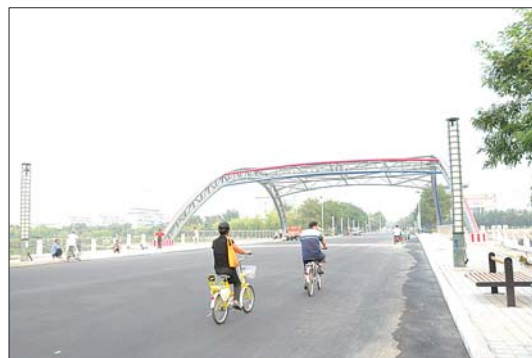
彩虹桥由之前的人行桥改造成了车行桥。
