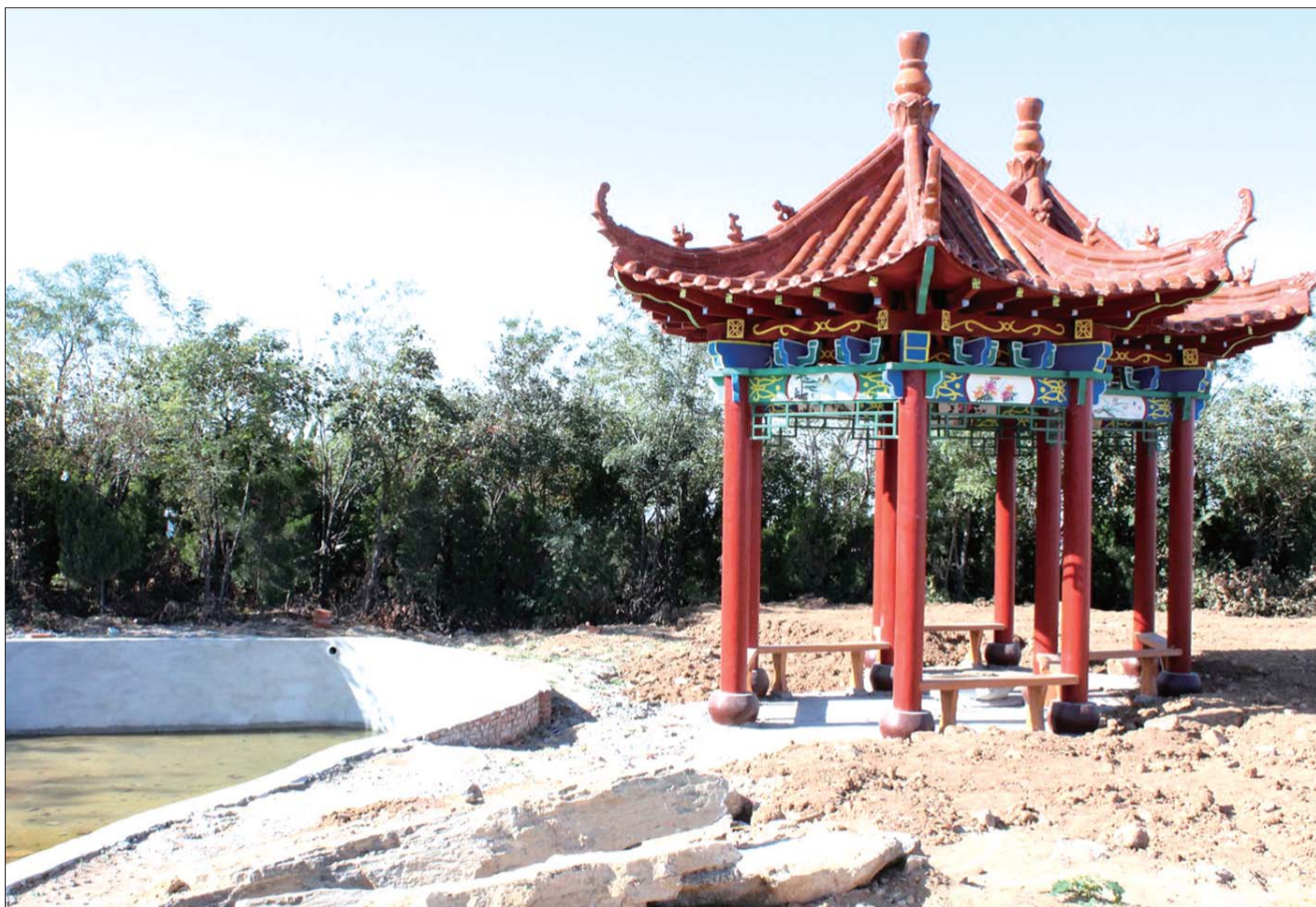
涵玉山半山腰处已完成健身、娱乐广场和双子亭建设。
