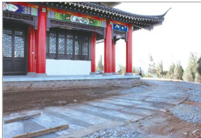
大山坡山体公园的山顶正在进行地面铺设。
