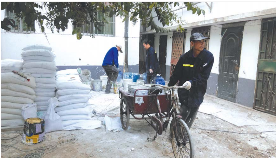
► 樱花园小区正在进行改造。
