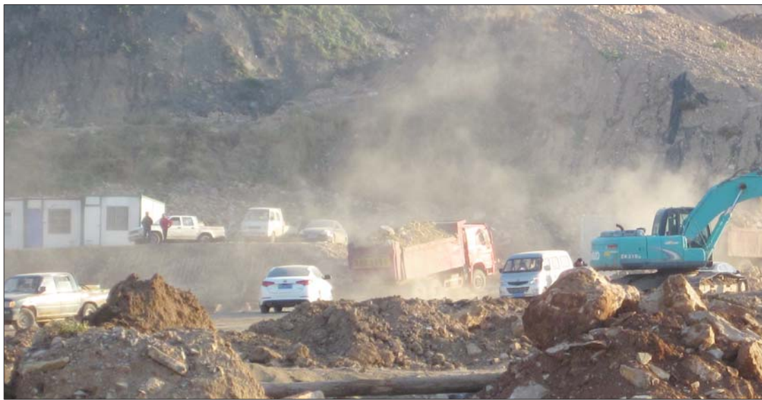
10月30日下午,济南高新区绿城玉兰花园项目施工现场,扬尘四起。 本报记者 刘德峰 摄
