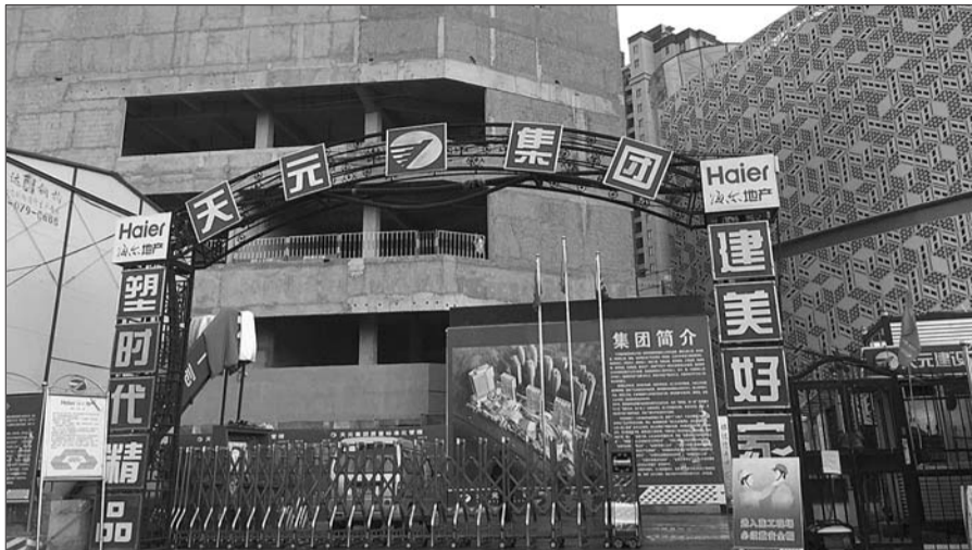
由天元集团负责建设的重庆路99号项目工地。 本报记者 吕璐 摄
