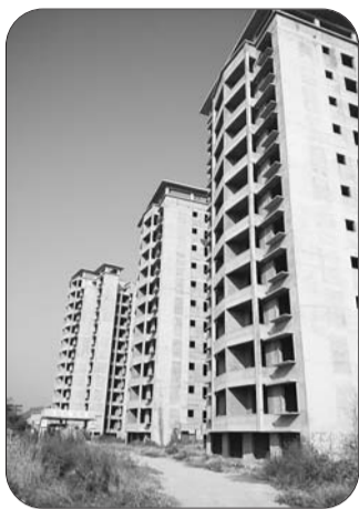
▲楼盘主体结构已经建成,却没有钱再建下去。
