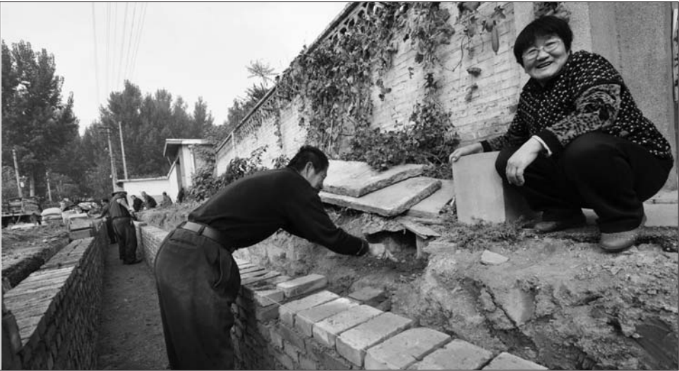
西杨堤村,工人正在修水沟。
