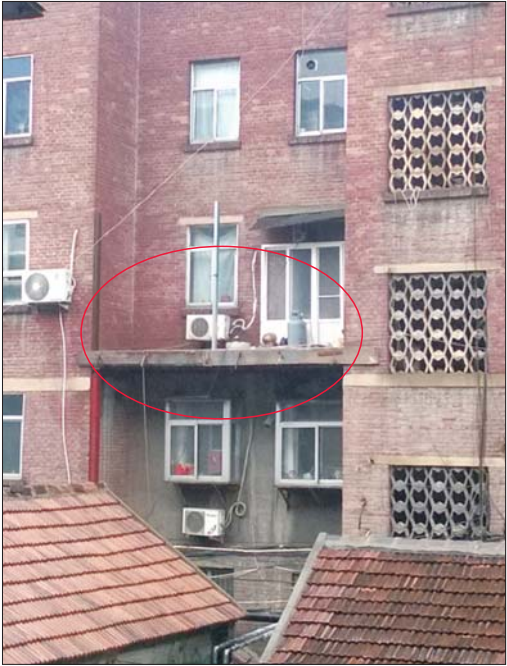
两个单元之间已经搭起了悬空平台,窗户也改成了推拉门。 本报见习记者 张朕宇 摄
