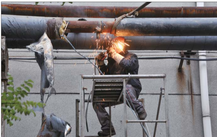
工作人员正在维修张钢宿舍区的供暖管道。 本报记者 王鸿哲 摄
