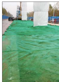
17日,济南西郊地铁R1线施工现场,工地用防尘网遮盖土地防止扬尘。 本报记者 周青先 摄
