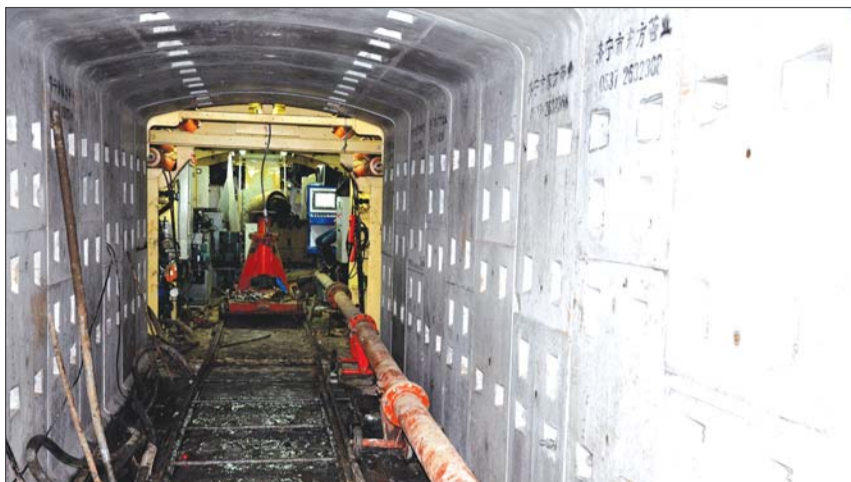
两拼矩形盾构工艺建造的地下管廊
