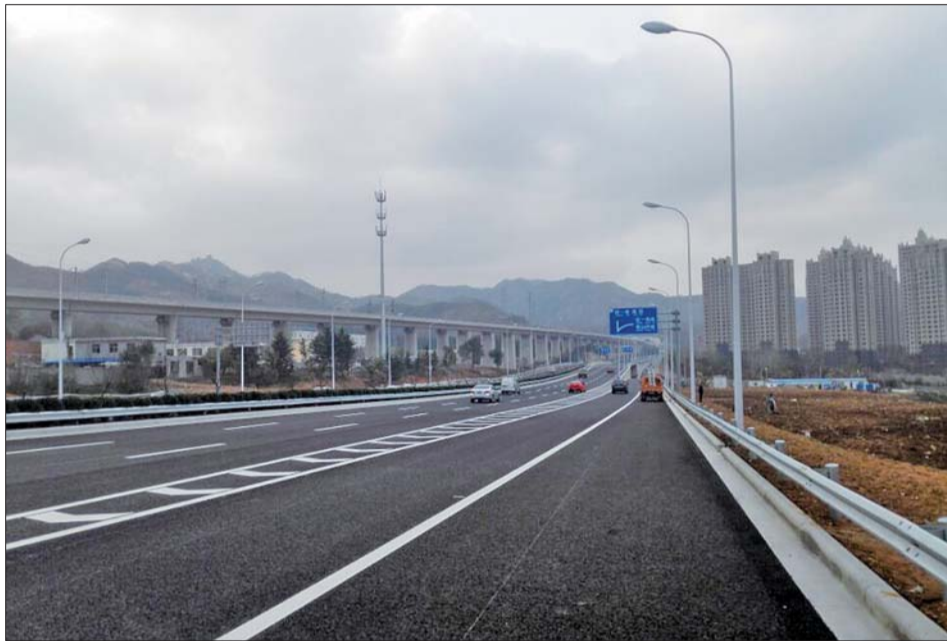
▲环山快速路主线(崂山立交南侧)道路拓宽一倍多。记者 李彦慧 通讯员 苑玉锋 摄
