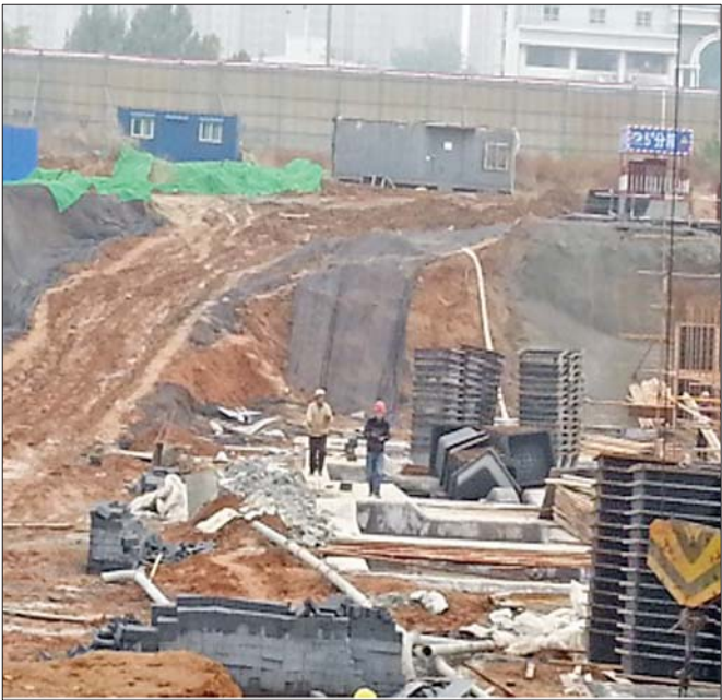
鲍德新天地润园项目现场。(资料片)
