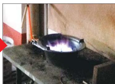
在东营市东营区龙居镇政府南侧的龙东村,村民为了免费用气,将天然气管线直接从村庄附近的“磕头机”旁接出来,经过铁桶的水过滤后,引到家里的灶头上做饭取暖。管道走线也不避学校和变压器,甚至绑在电线杆上,和村里的电线、光缆缠在一起,存在很大的安全隐患。据村民介绍,私接油井上的伴生气在当地早已不是新鲜事,村民对此已司空见惯。 本报记者 摄
