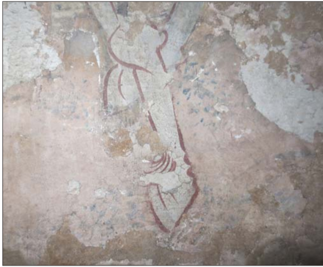
东壁四区部分位置修复后。
