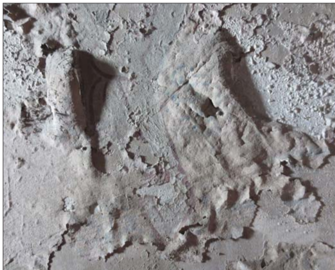
东壁四区部分位置修复前。
