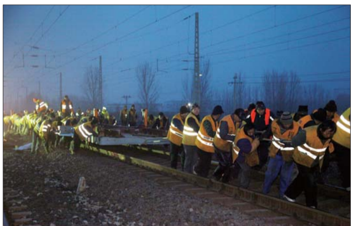
线路工更换道岔。
