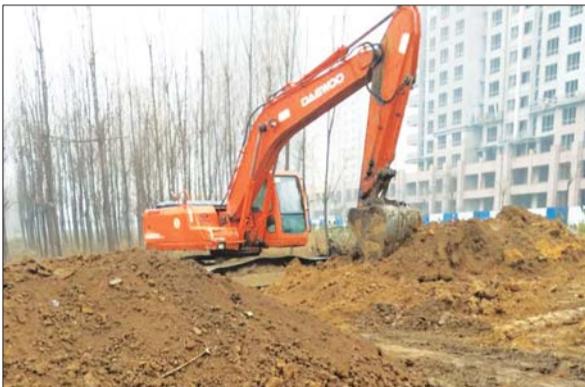
11日,龙城国际小区外面的暖气管道工程已暂停施工。 本报记者 李大鹏 摄
