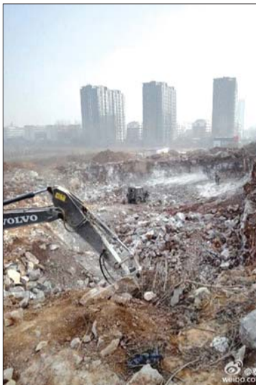
环保部门督查发现,泰城一工地仍在施工。(泰安环境)
